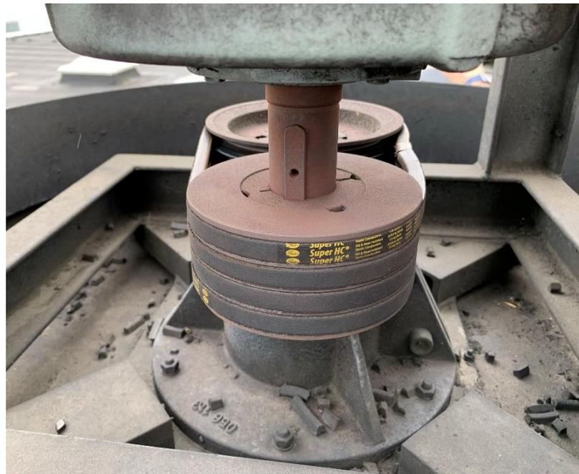
Danneggiamento dell'impianto di aspirazione per corrosione (ventola e guaina)
