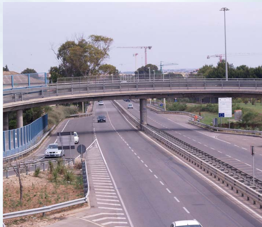
vista generale dell'area interessata dall'installazione
